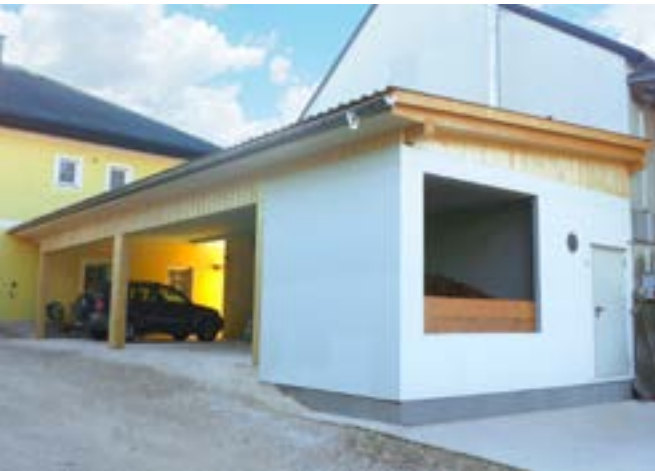
Enkelvoudige verwarmingscontainer bij woningbouw.
